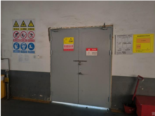
危险废物仓库
