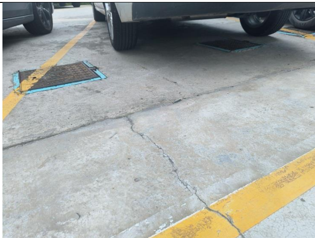
废水处理设施（化粪池）
