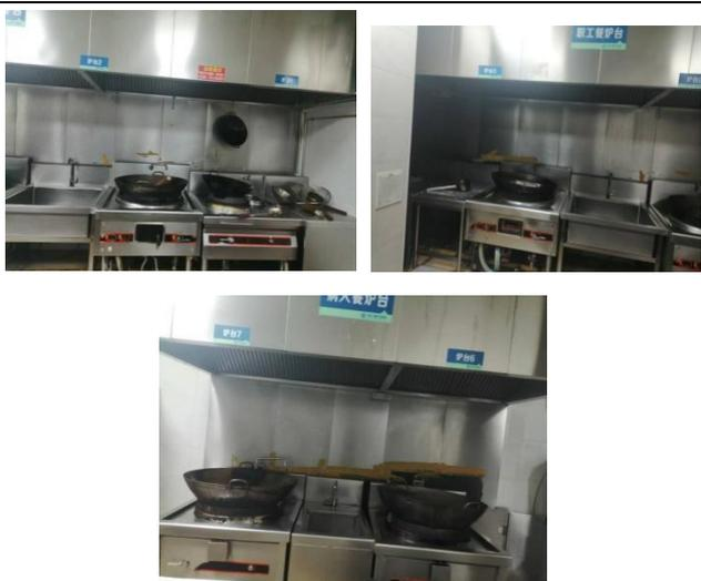
油烟废气收集装置
