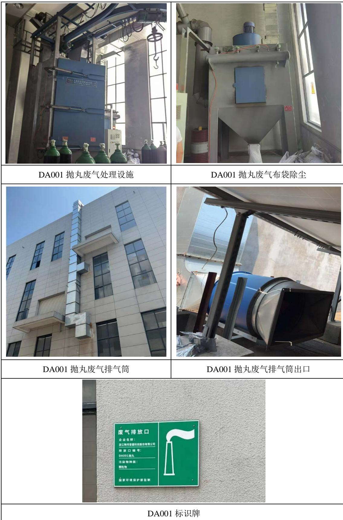
图4.1-3 DA001 抛丸废气采样口、标识牌照片
