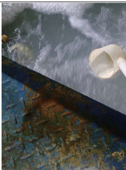
生产废水进口
