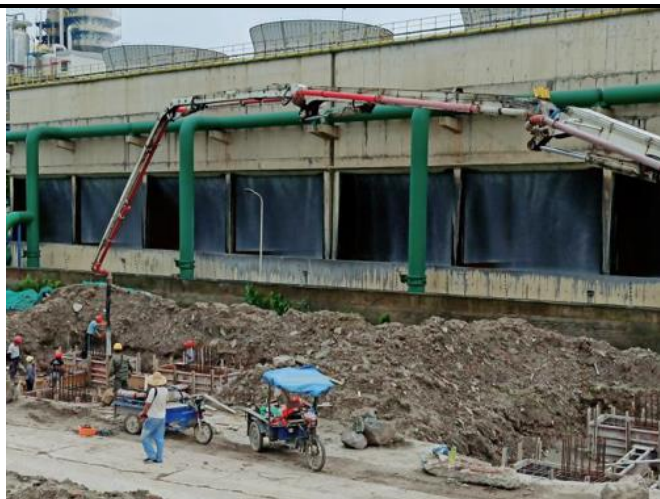
项目起点（浇筑）
