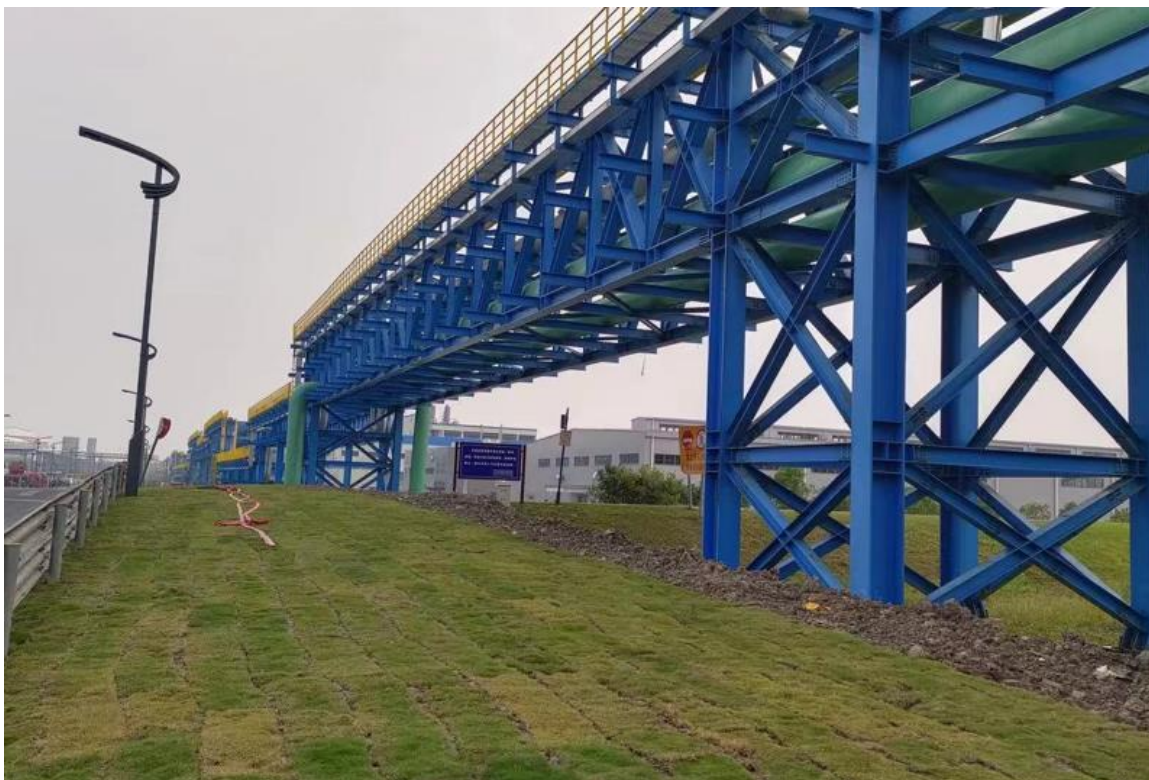
施工沿线已复绿
