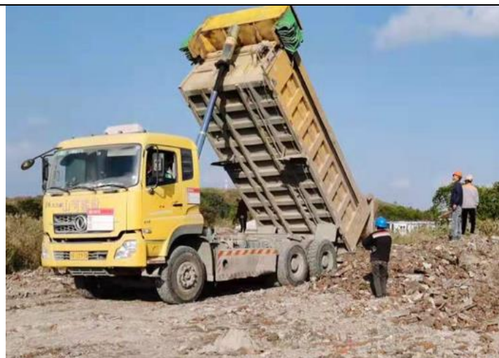
项目终点（土石方回填）
