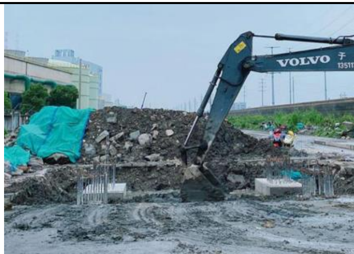
项目卫星能源段（土石方开挖）
