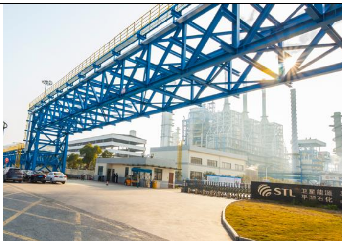
现场照片（卫星能源段）
