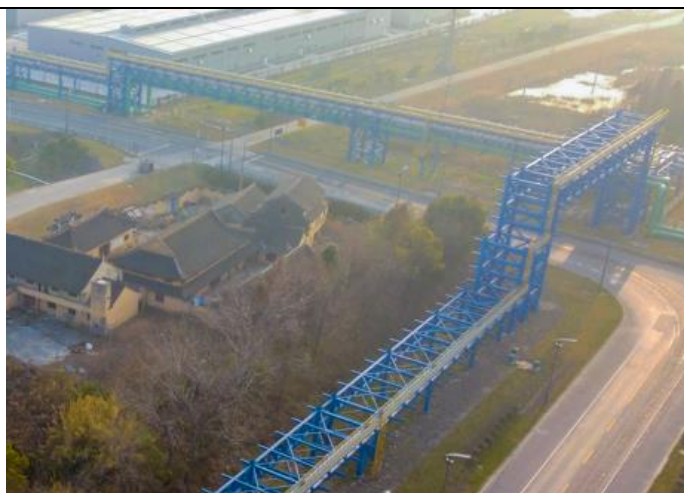
现场照片（海林禅寺段）
