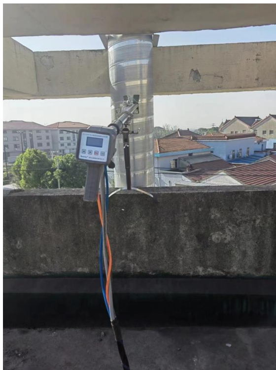
投料、混合、磨粉粉尘废气处理设施
