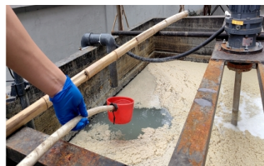
废水处理设施进口
