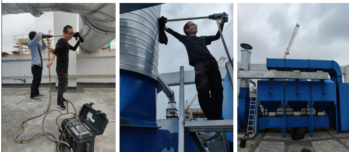
树脂有组织废气进出口及净化设备
