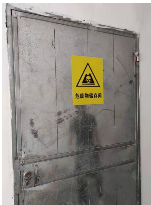
危险废物暂存场所
