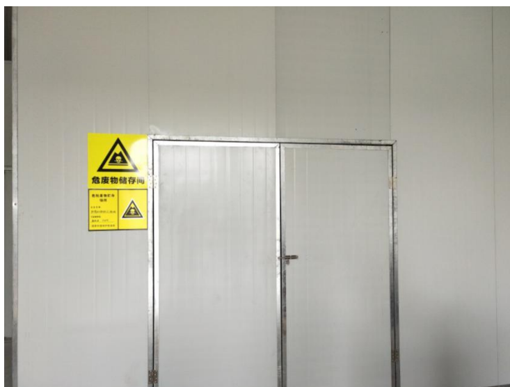
危险废物暂存场所
