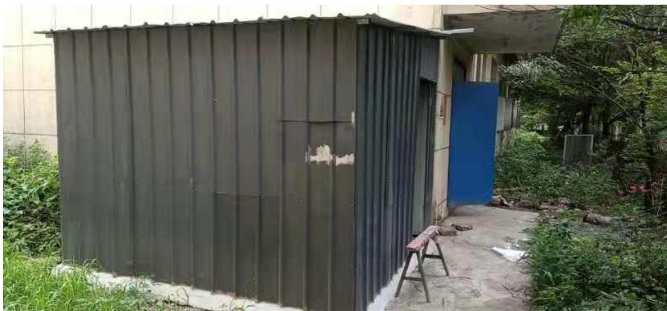
危险废物暂存场所
