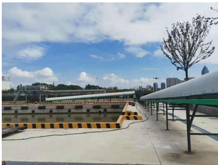
现场除尘设施
