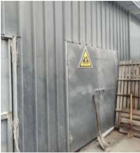
危险废物暂存场所
