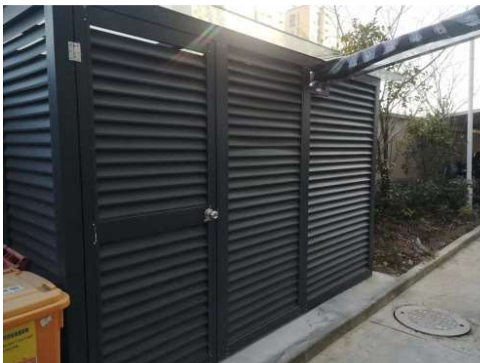
废水处理设施
