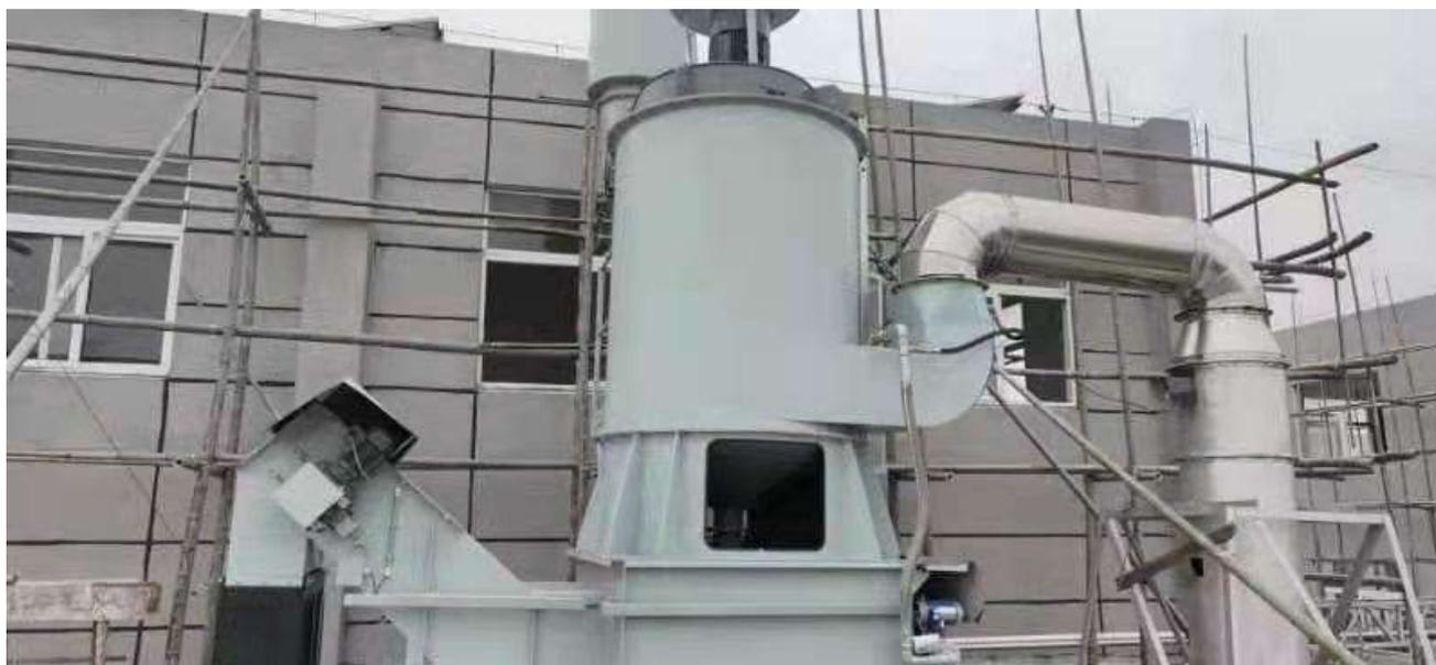
熔化炉废气处理设备
