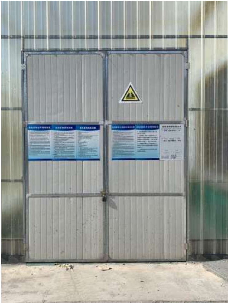
危险废物暂存场所
