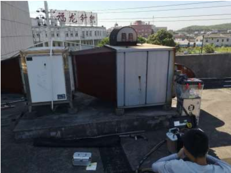
图 4-1 废气现场监测图
