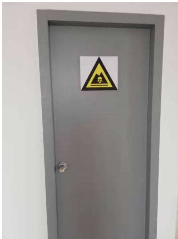
图 4-1 危险废物暂存场所
