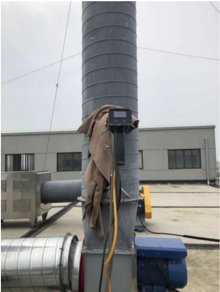
图 4-1 废气现场监测图
