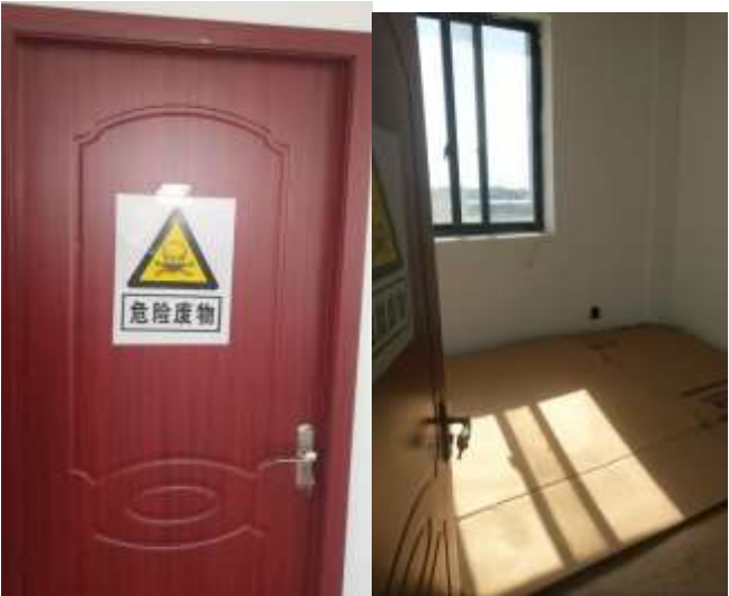
图 4-3 危险废物暂存场所
