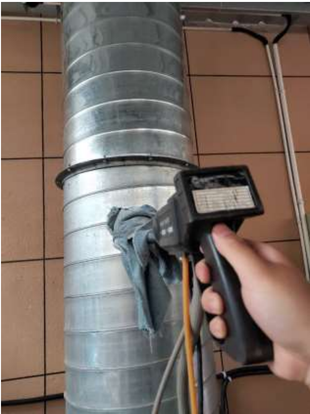
图 4-4 废气有组织现场监测图
