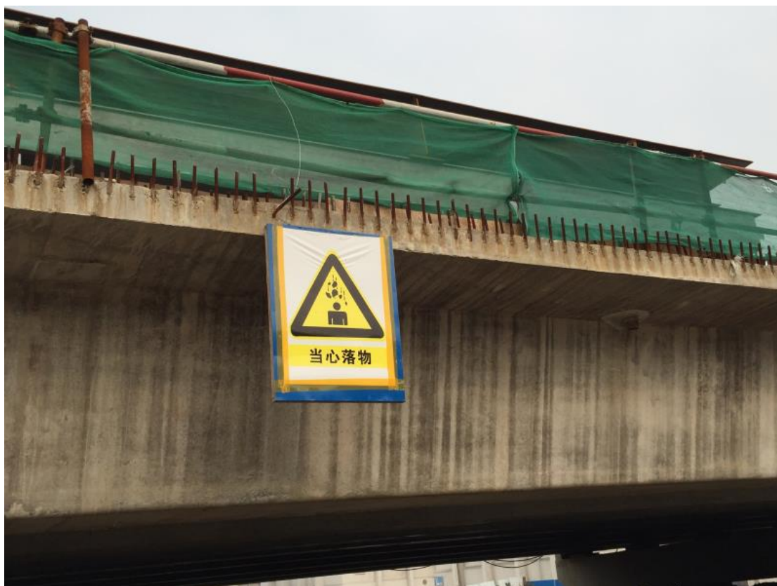
两侧挂网防扬尘
