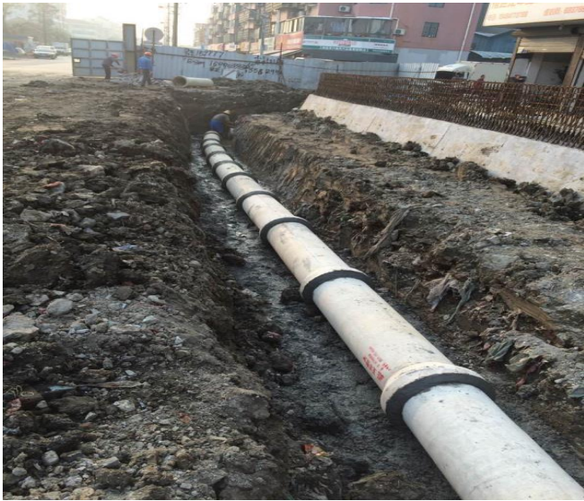
新建雨水管网
