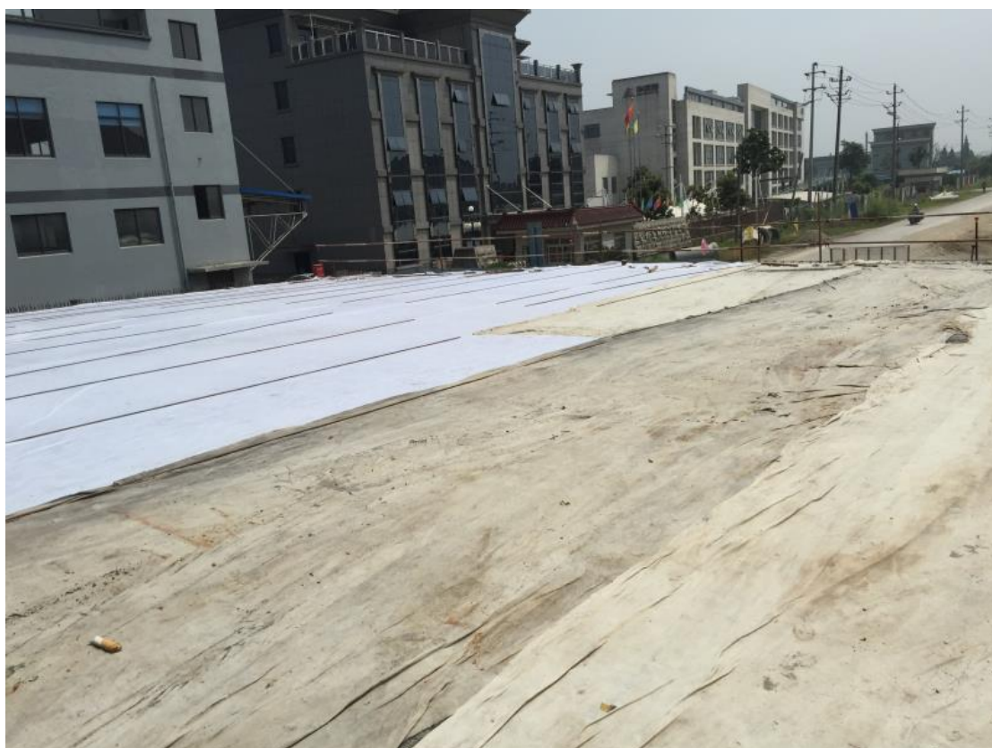
路基覆盖湿水养护
