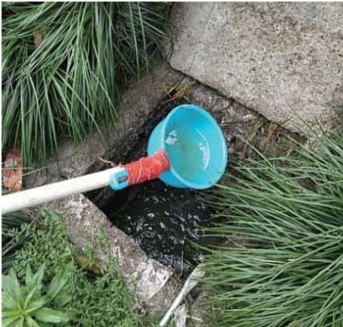
生活污水入网口
