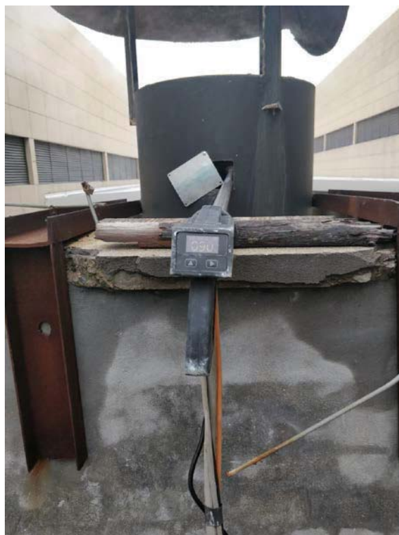
锅炉有组织采样
